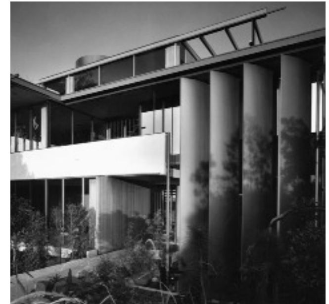
Imágenes: VDL II, Richard Neutra, 1966. Sala de estar y detalle de brise-soleils en fachada . [Procedencia: Torroja, 1968]
